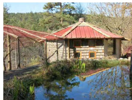
Murs nord et est du poulailler
